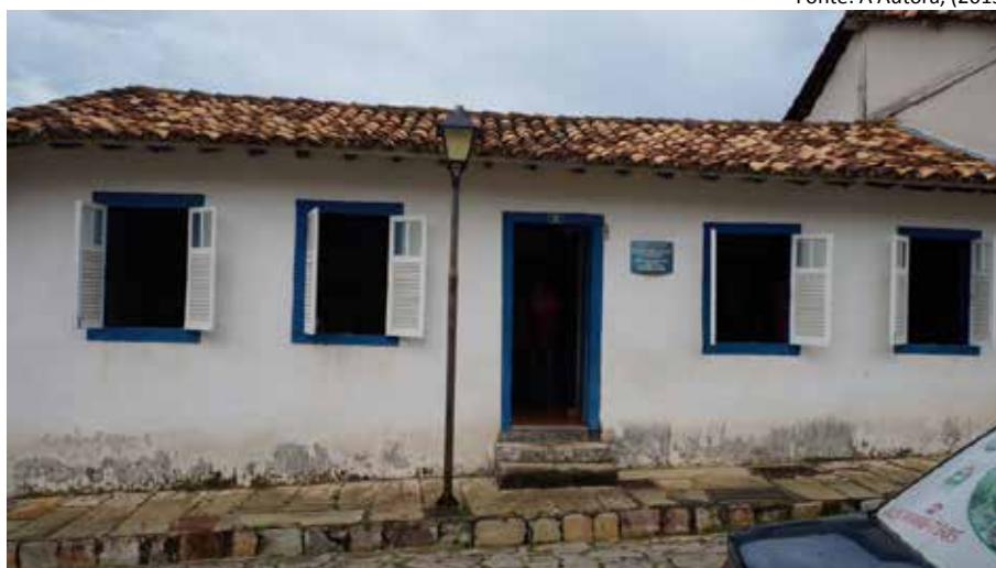
Figura 10- Fundação Frei Simão Dorvi
