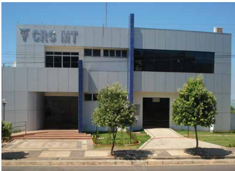
Foto nº 15 - Prédio atual do CRCMT.
