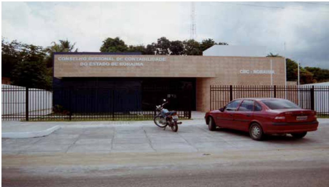
Figura 8 – Sede Própria do CRCRR
