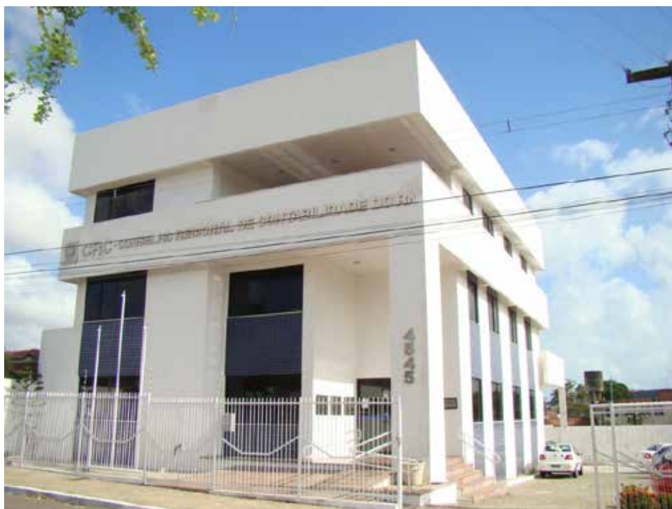
Figura 8 – Sede atual do CRCRN
